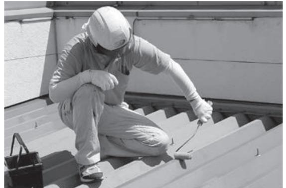
躍進本社の社屋・屋根根において熱交換塗料を塗装し(右写真参照)、熱交換効果に関するデータも取得しています。
