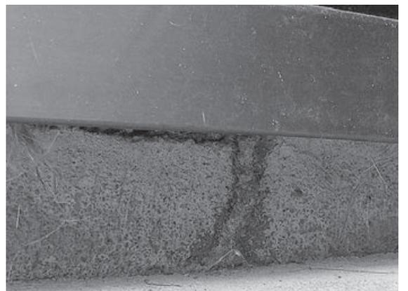
通常日陰となっている外壁下の、基礎の立ち上がり部分で発見された蟻道です。さらに、日が当たるフェンスの裏側の、日陰となっている基礎部分にも蟻道が形成されます。縁側の上がり框部分のひび割れにも蟻道が形成されます。
