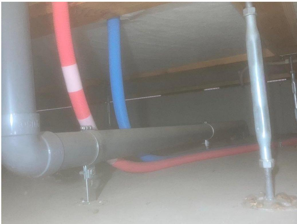
躍進では住宅の床下点検業務を実施しています。5年点検では、床下のシロアリと腐朽菌、排水管系の水漏れ等を確認しています。そして、お風呂場床下の排水管の汚れも発見します。さらにシロアリ以外の害虫に遭遇することもしばしばです。
