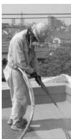
「ジェットスプレーシステム」は、車両に全自動コンピュータと材料供給タンクを搭載し二本のホースで同時に稼働させます。超大型規模現場にはお薦めです。
