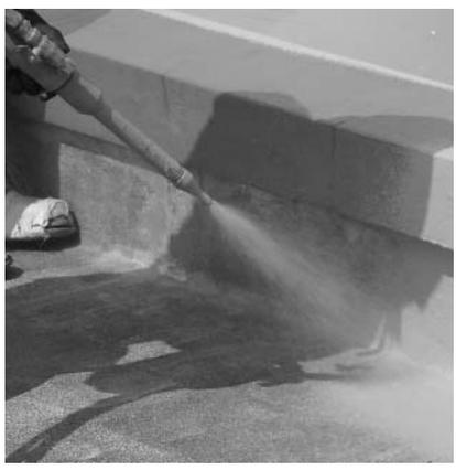
躍進がご提案する「ジェットスプレー防水システム」によるフクレが発生しにくいのです。他のスプレー工法はエアレススプレーのため塗膜にエア層は形成されず、水蒸気透過性が微量で下地の残留水分によるフクレが発生しやすいのです。
