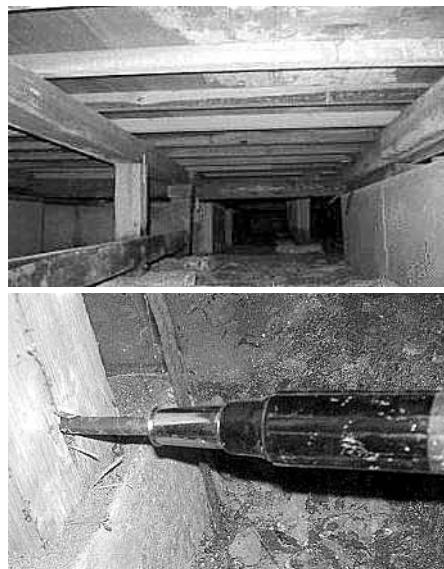
木材腐朽菌は、不要な水分によって繁殖し、木材の主成分であるセルロースやヘミセルロースなどを分解して木材を多孔質に変化させ強度を下げるのです。
