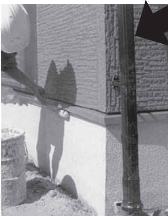
多孔質ローラーを使い、ムラのないように均一に塗り付けて完了。
