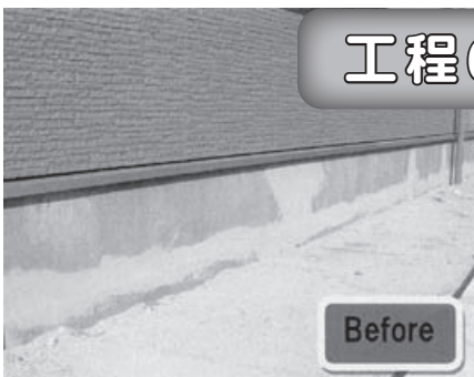
工事前の基礎巾木(段差処理済み)
