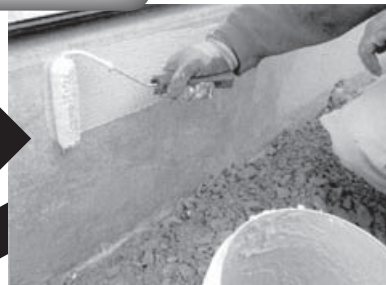
ウールローラーを使い、巣穴を埋めながら、基礎ガードを塗り付けていきます。
