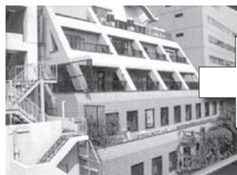
東京・六本木の現場 before
