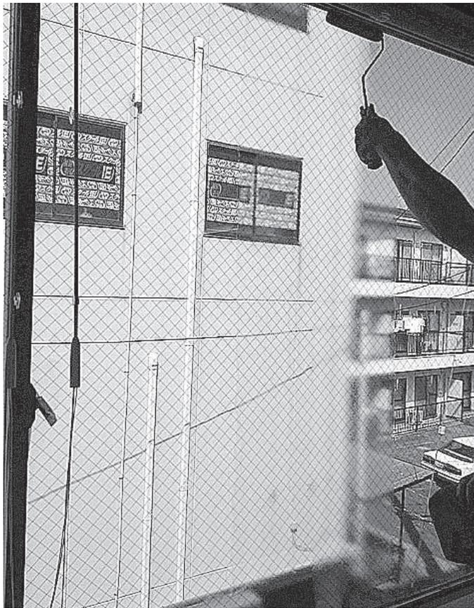
の現場の施工例ですが、ローラーによる塗布で「断熱ガラス」に早変わりします。
