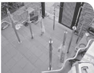
QUNETTOの支柱を立て
