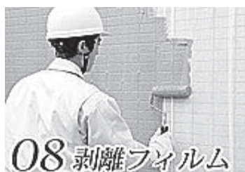
08 剥離フィルム メッシュの上から02と同じ剥離型養生フィルムを塗布します。
