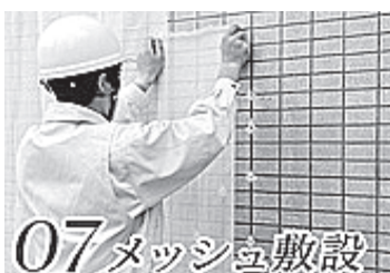
07 メッシュ敷設 圧着金具を外し、養生フィルムの上にメッシュを重ねます。
