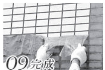
09 完成 乾燥したら引きはがし、目地の穴をモルタルで埋め、完成です。
