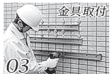
03 金具取付 押さえ金具を取り付けます。(最下段のストッパーを先に締付)
