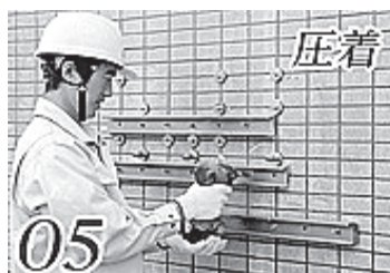
05 圧着 圧着金具を締めつけ、注入剤を隅々まで行き渡させます。
