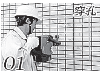
01 穿孔 打診検査で浮き箇所を特定し、注入用の穴を穿孔します。
