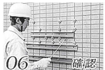
06 確認 打診で浮きが無くなったことを確認し、乾燥させます。
