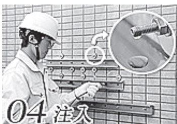
04 注入 樹脂注入剤を注入。上部金具よりあふれてきたら注入完了。
