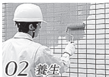
02 養生 剥離型養生フィルムを塗布します。
