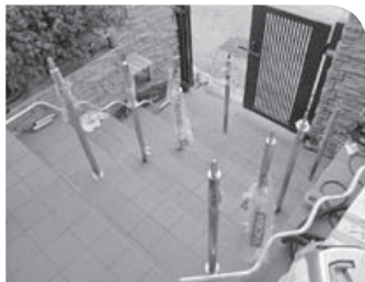
QUNETTOの支柱を立て
