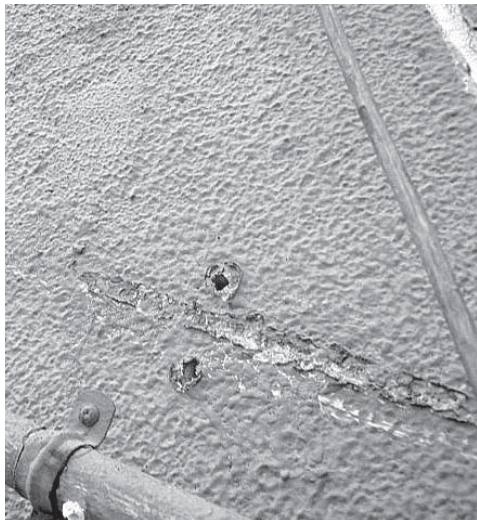
クラックやサッシ周りの傷みを放置しておくと、雨水が壁体内に侵入し、シロアリや木材腐朽菌の発生を誘発します。
