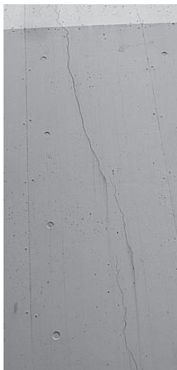
左の写真のような軽微なクラックも見逃してはいけません。壁の内側が右の写真のような状態になることもあります。
