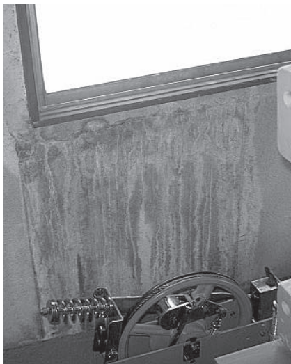
左の写真のような軽微なクラックも見逃してはいけません。壁の内側が右の写真のような状態になることもあります。
