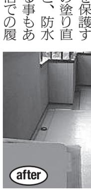
FRP防水は一〇年保証です。しかし、防水層を保護するトップコートの塗り直しなどをしないと、防水効果が薄れている事もあります。日常生活での履物によるトップコートの損傷や、ドレン部分の詰まりによるオーバーフロなどには、適切な対策が必要です。
