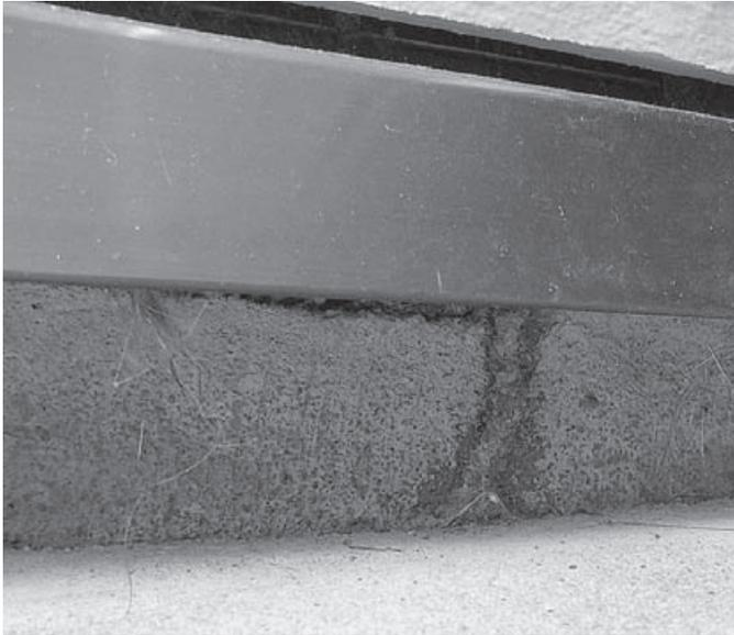
躍進のリフォーム総合提案「足場パック」では、現在サマーキャンペーンを実施しています。シロアリはこの時期が最も活発に活動します。「足場パック」の床下調査にも依頼が多数寄せられていますが、実は意外なところに蟻害が及んでいるのです。シロアリは、暗く湿度も高く無風状態となる蟻道を形成して、その中を移動します。通常の場合、シロアリは地中の巣から蟻道を通って床下に侵入し、土台などの木材を食害します。しかし、蟻道は床下ばかりに形成されるのではなく、左上の写真は、通常日陰となっている外壁下の基礎の立ち上がり部分で発見された蟻道です。さらに、右下の二枚の写真では、日が当たるフエンスの裏側の、日陰となっている基礎部分に蟻道が確認されています。左下の写真の、縁側の上がり框部分のひび割れも蟻道形成の根拠となります。まずは躍進に調査依頼し早期発見を。お電話をお待ちしています。
